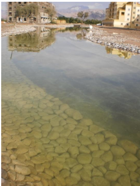
Celkový pohled na lag2 z můstku mezi lag 2 a lag 3. Dno je pokryto tvořícím se šedým blátem, místy zelená přisedlá řasa. Foto ze 7.1.2014
